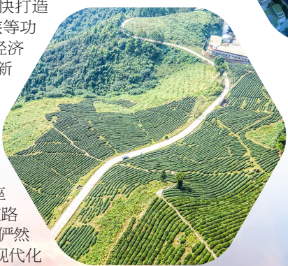
明月山乡村振兴示范带建设工程垫江县沙坪镇东印茶山
