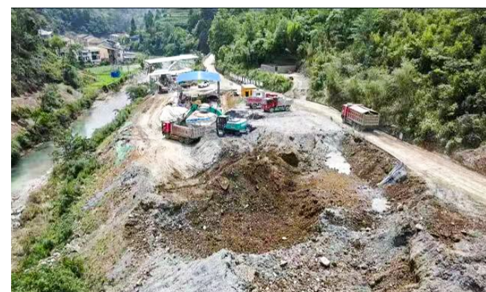
洪塘水库施工现场。 实习记者 唐秀夫 摄
