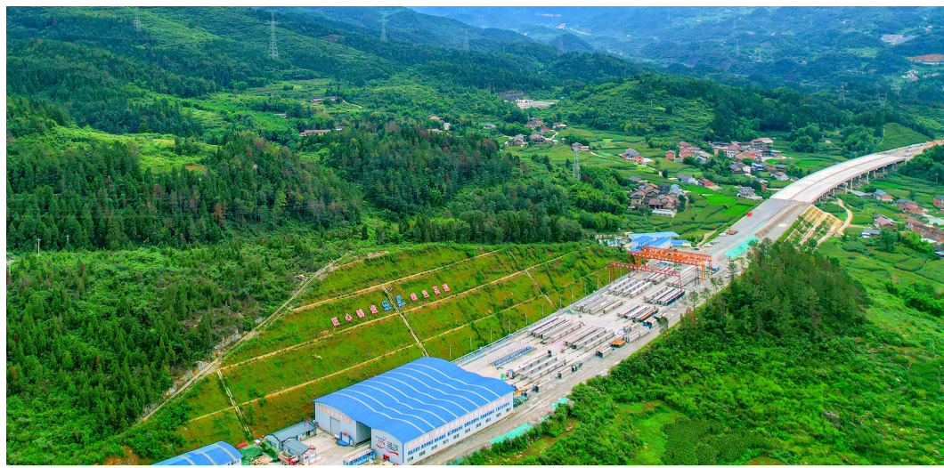
渝湘复线高速公路巴彭路5标段预制梁厂全景。
