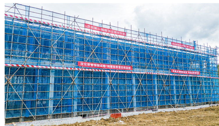
建设中的生产楼。
