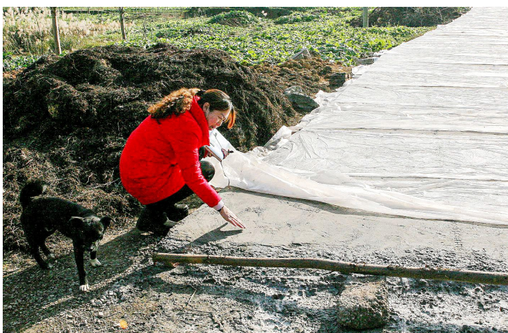
朱永琴在查看道路硬化情况。 记者 黎明 摄
