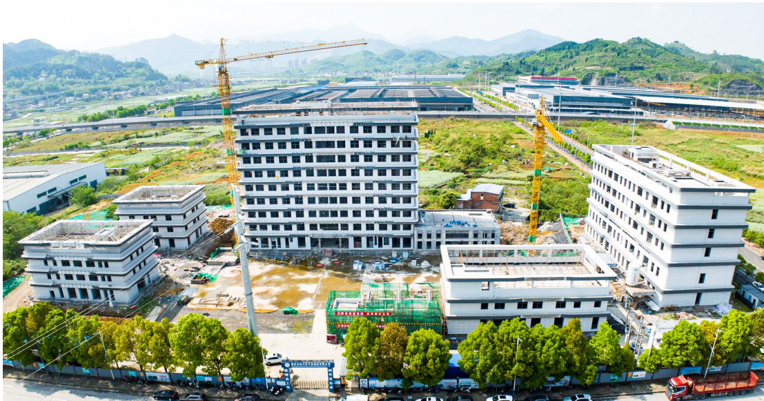
4月14日,区疾控中心新建项目建设现场,工人正在进行外墙装饰。
