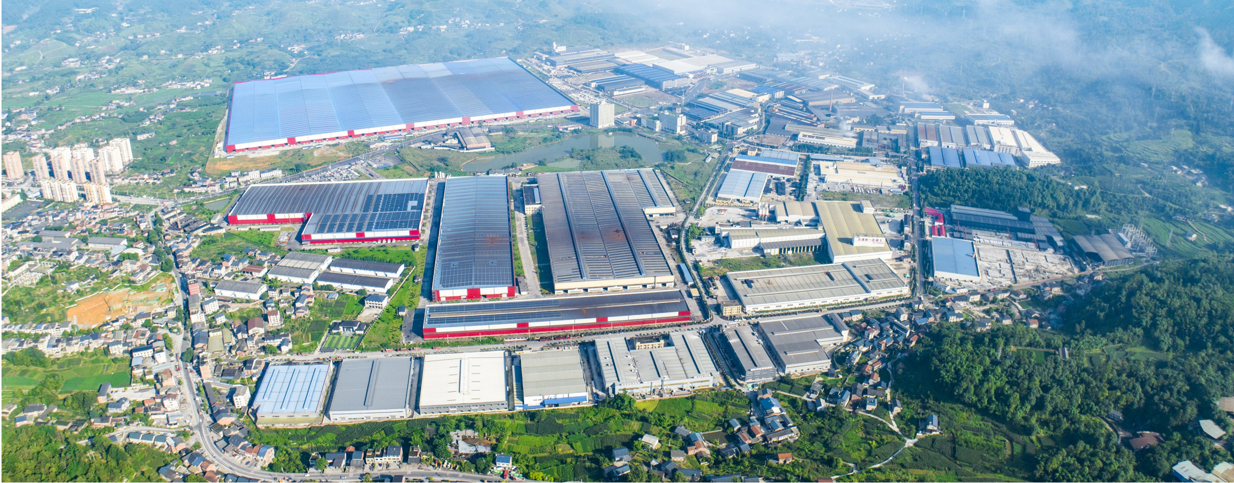
工业园区南平组团。 记者 陈姗 摄
