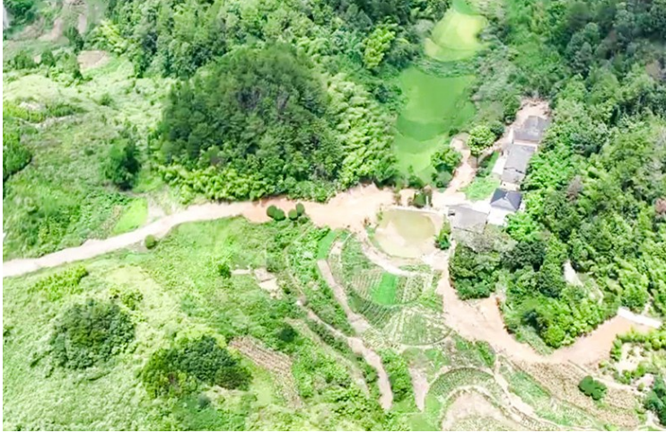
▲航拍视角下正在修建中的“断头路”即将贯通。 ▶道路施工现场,挖掘机在开展拓宽、平整作业。
