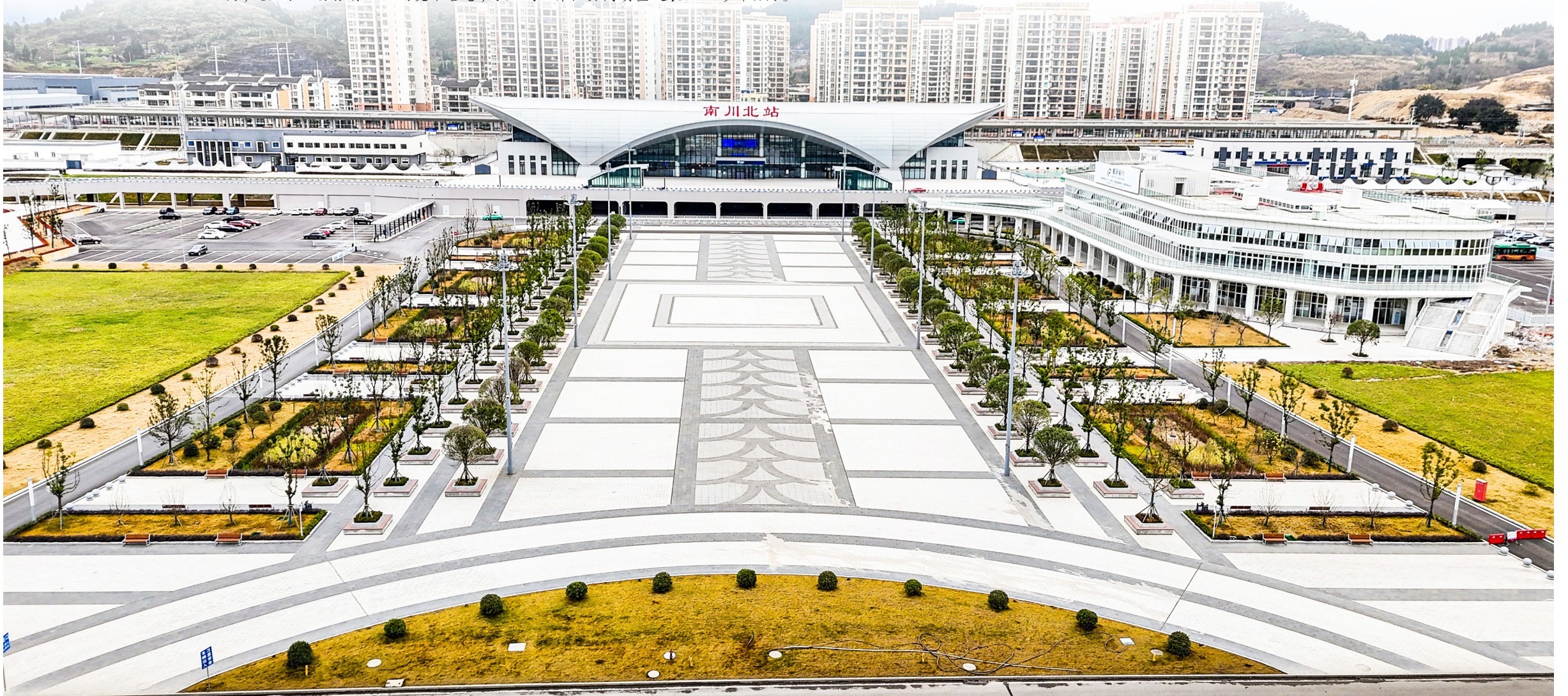
渝厦高铁南川北站。
