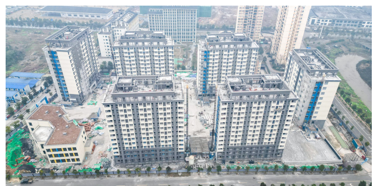
大观中医药产业园保障性租赁住房主体工程完工,正在进行装饰装修。
