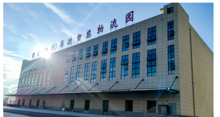
昌达智慧物流园项目快递物流中心已投用。
