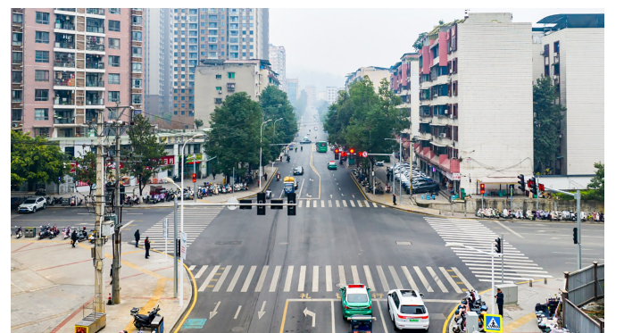
北环路城中村基础设施改造。
