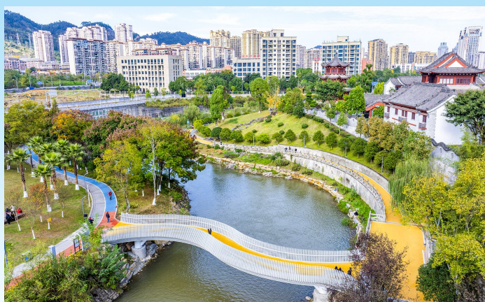
大溪河综合治理工程。
